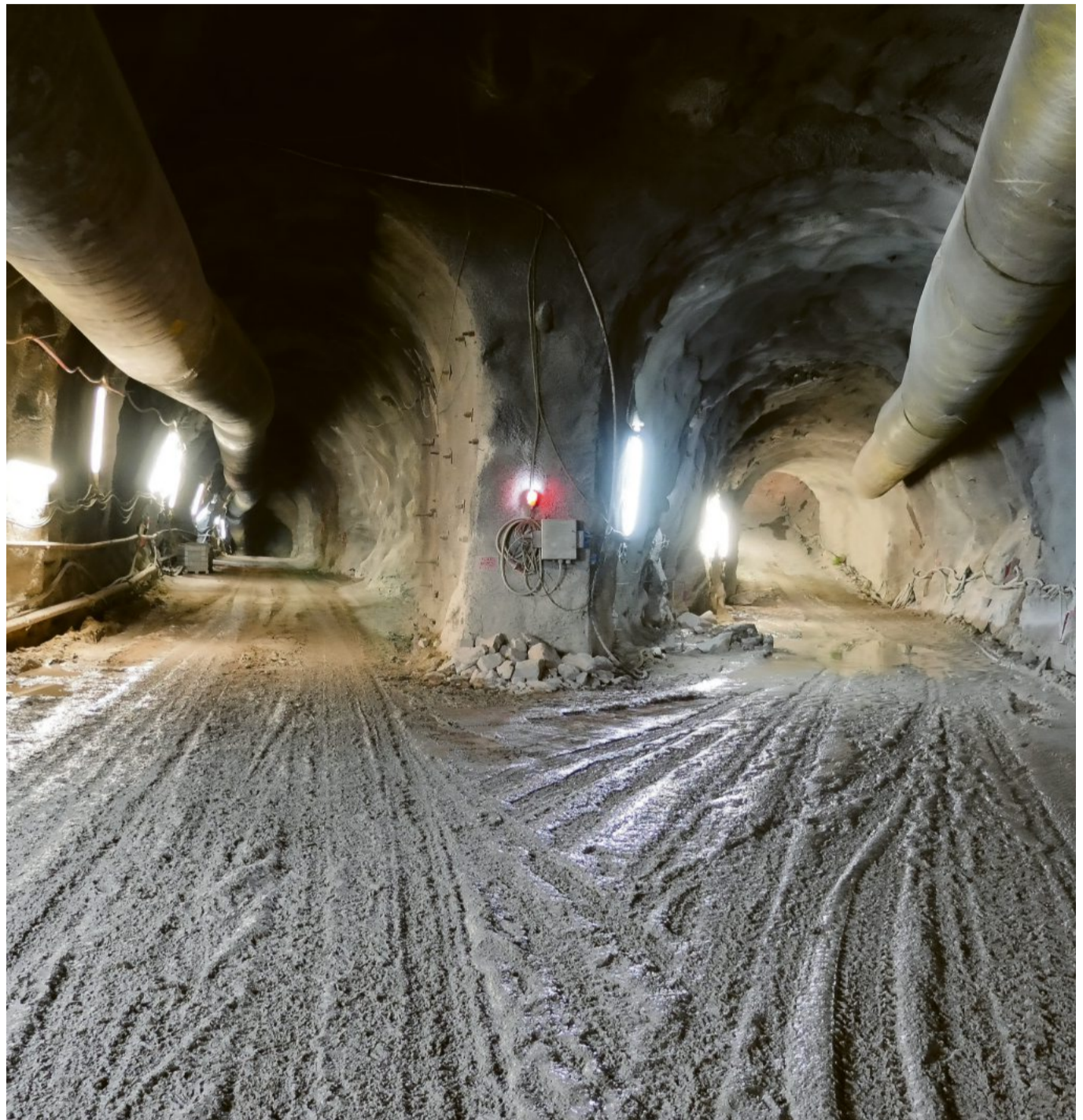
Noch weitgehend trocken: Künftig wird eine Menge Wasser durch diese hohle Gasse strömen.
